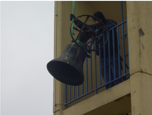
Die kleine Glocke wird abgeseilt.
